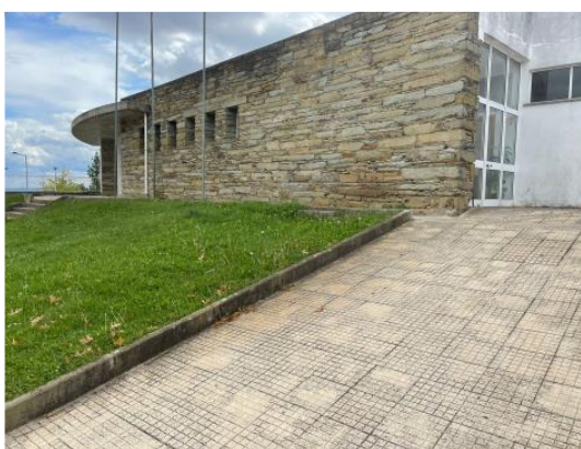
Figura 31- Porta de acesso privado
