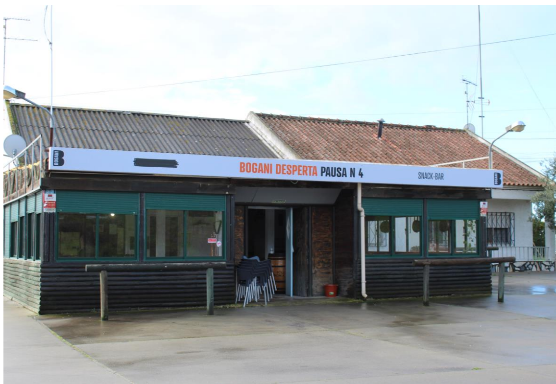
Figura 8 - Frente exterior do estabelecimento
