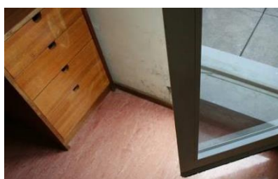
Figura 19- Desgaste e degradação dos equipamentos
