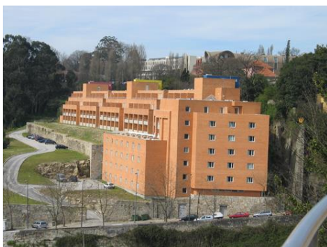
Figura 7- Fachada Sul e nascente do edifício
