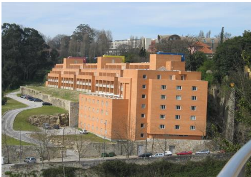
Figura 56- Vista geral do edifício
