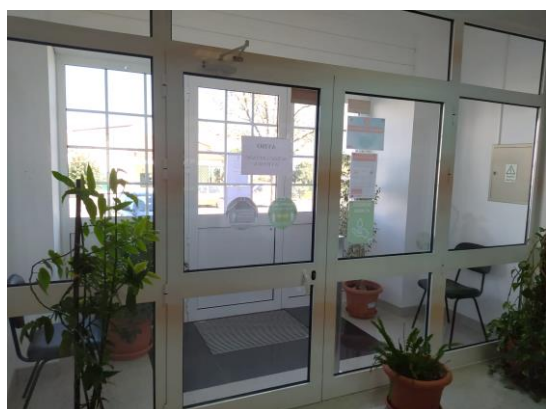
Figura 7 – Entrada piso térreo
