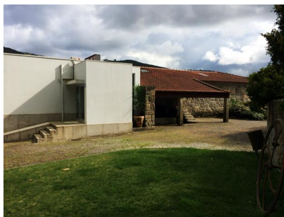
Figura 3 - Fachada norte do edifício
