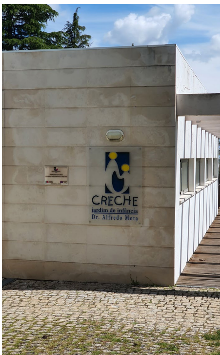
Figura 24 - Lateral do edifício destinado à creche, Jardim de Infância Dr. Alfredo da Mota. (Fonte: Do Autor).
