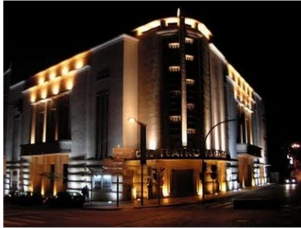
Imagem1.0 - Fachada Cine-Teatro Avenida, Castelo Branco.
