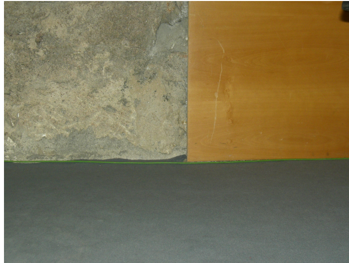
Imagem 6.0 - Detalhe dos materiais de construção Cine-Teatro Avenida.
