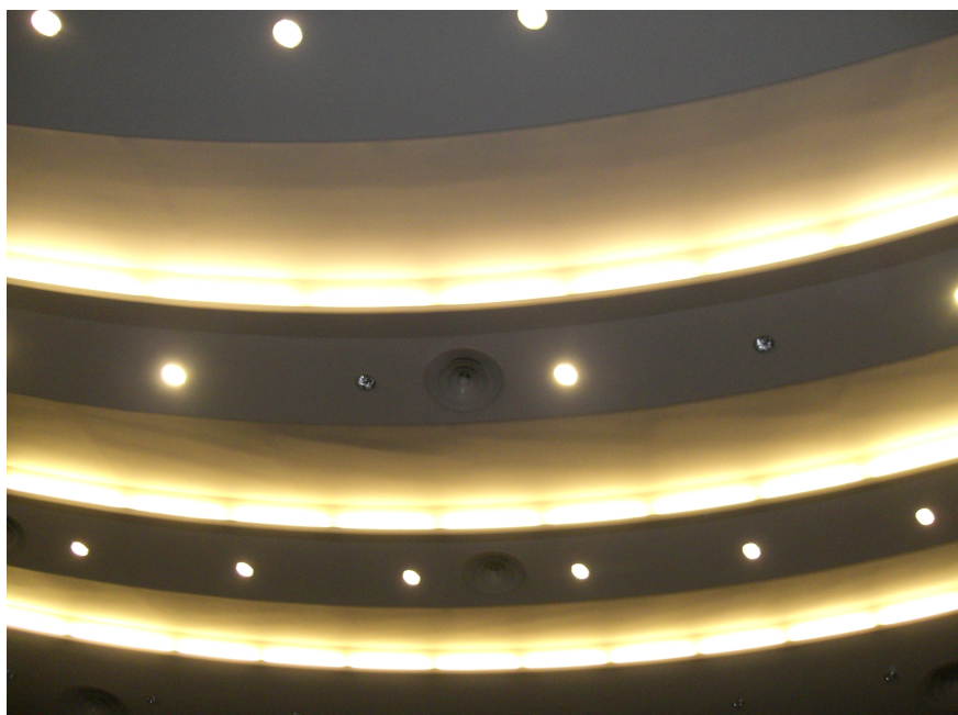
Imagem 7.0 - Detalhe tecto Cine-Teatro Avenida.
