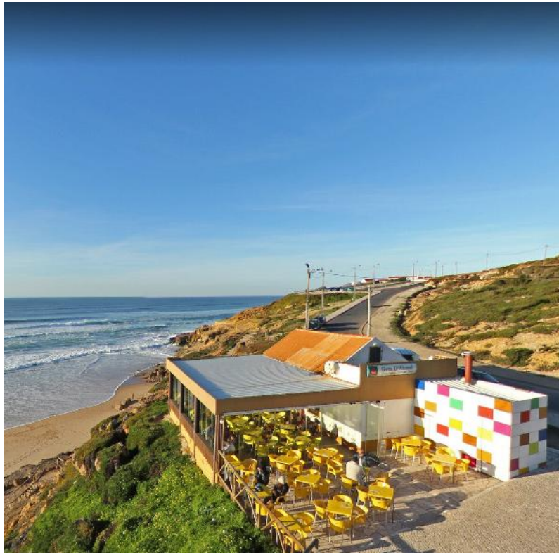
Figura 2 - Exterior do espaço, imagem do Google Maps
