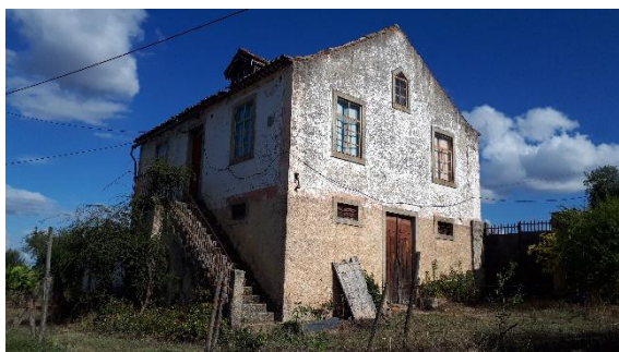
Figura 1- Moradia vista do lado direito
