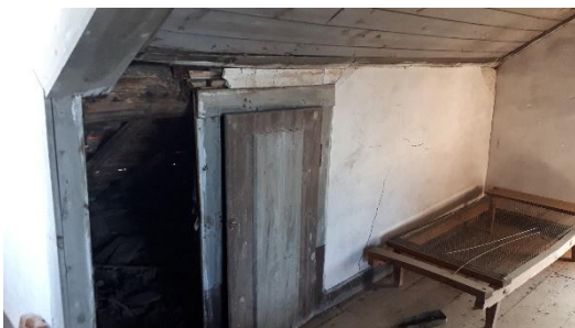
Figura 8- Zona de arrumos
