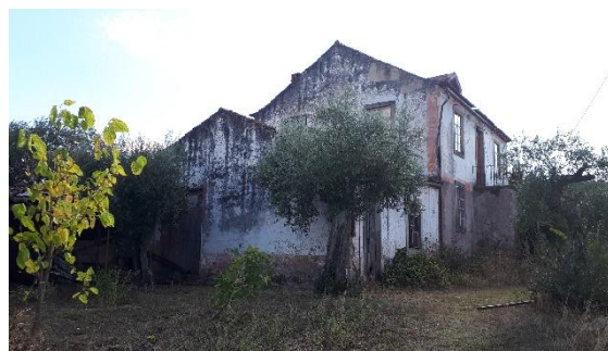
Figura 2- Moradia vista do lado esquerdo
