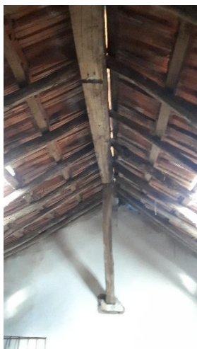
Figura 13- Vista interior do telhado
