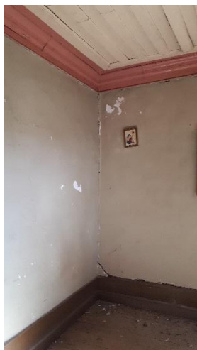
Figura 14- Visualização do descasque das paredes
