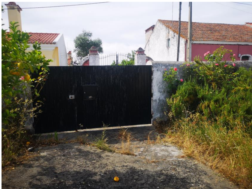
Figura 51 - Vista para entrada principal.
