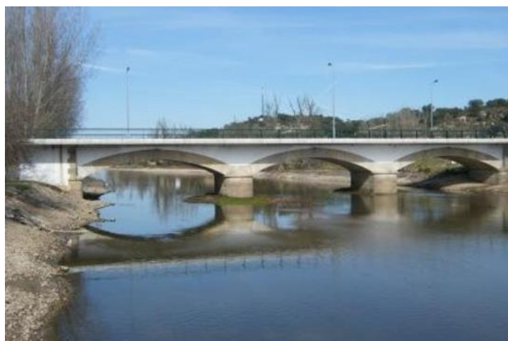
Figura 7 - Ponte Romana de Ponte-de-Sôr. Acedido a 21 de Fevereiro de 2019 em: https://www.tripadvisor.pt/LocationPhotos-g3861917-Ponte_de_Sor_Portalegre_District_Alentejo.html
