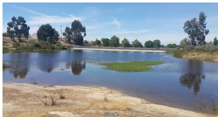
Figura 4 - Barragem da Cunheira. Fotografia tirada por PAULO, João. Acedido a 29 de fevereiro de 2019 em: https://www.google.com/maps/place/Cunheira/@39.3203512,-7.8091064,3a,75y,90t/data=!3m8!1e2!3m6!1sAF1QipMoLJPJVzQuwqJ_NZvZ5-nGVx50IqN0e2uvW9-5!2e10!3e12!6sht
