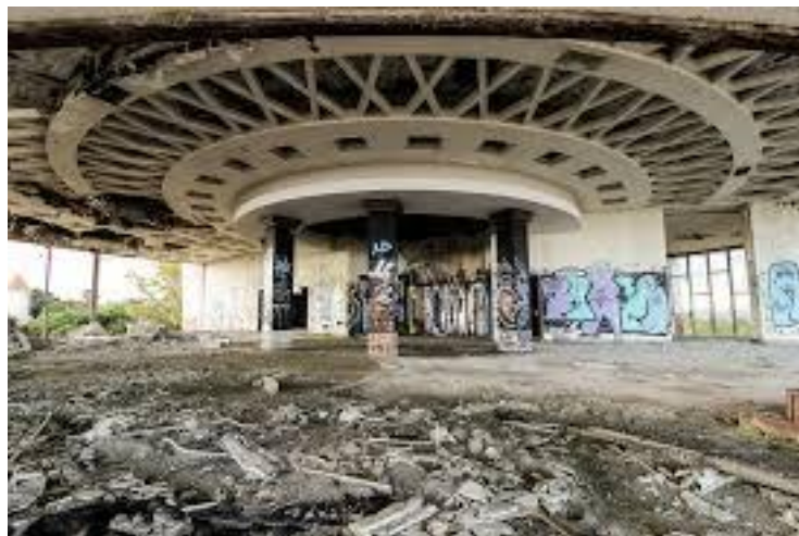
Figura64- Interior do 2º piso - zona do palco
