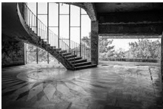
Figura 42 - interior do 1º piso escadas em espiral
