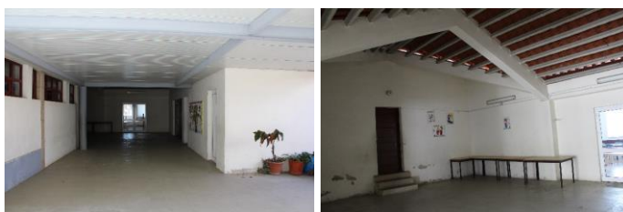
Figuras 7 e 8 - Pátio do Pavilhão A
