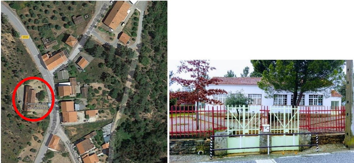
Figuras 1 e 2 - Localização da Escola Primária e Fachada da Escola
