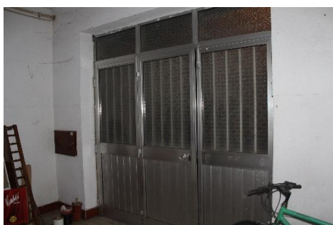
Figura 5- Interior Piso zero
