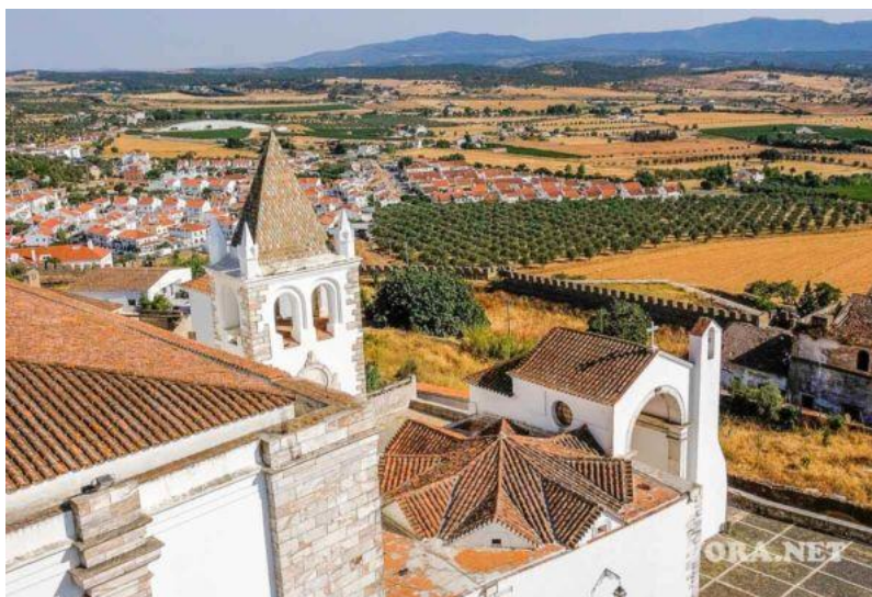
Fig. 7 - Vista do Castelo de Estremoz sobre a zona sul da cidade
