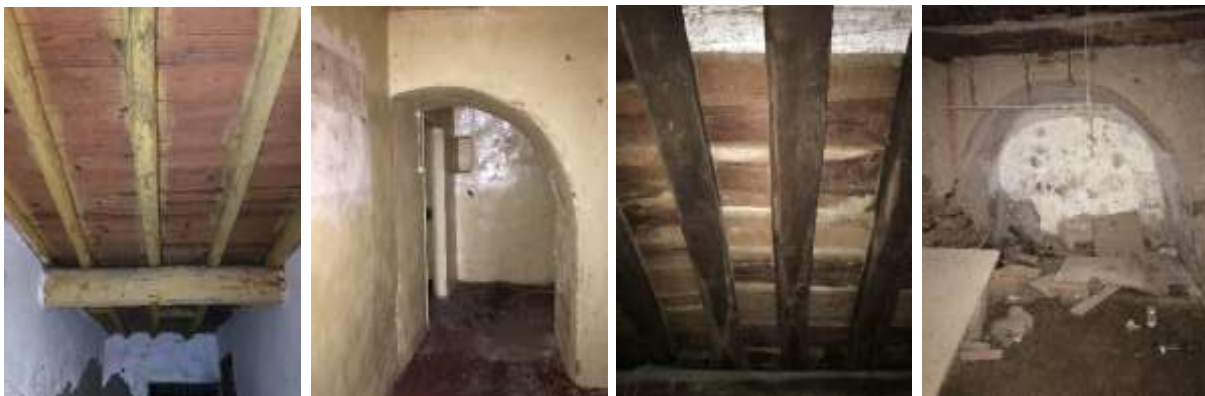
Figura12- Pormenor de teto Figura 13- Pormenor de Arco Figura 14- Pormenor de teto Figura 15- Pormenor de Arco
