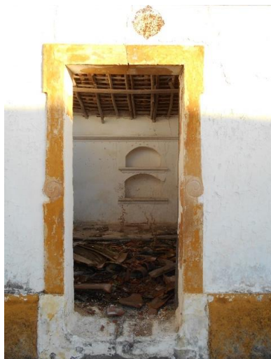
Figura 25 - Pormenor de ornamentos em torno de uma porta de uma habitação
