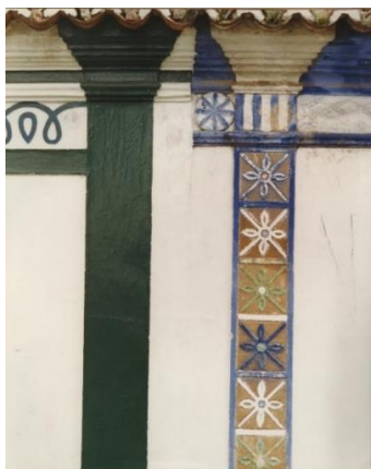
Figura 49 - Pormenor de decoração de uma fachada
