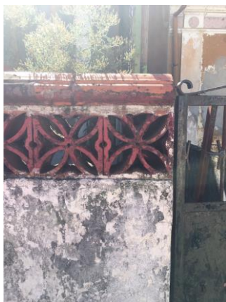
Figura 50 - Muro de uma casa típica
