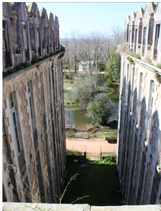
Fig. 10 – Fotografia da vista de uma das janelas do sótão | Hotel SPA Termal- edifício a intervir
