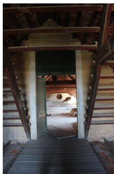
Figura 4 - uma das repartições do sótão dos Pavilhões.
