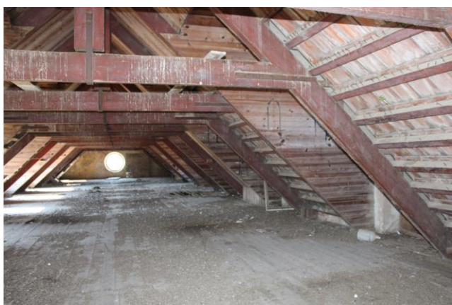
Figura 3 - Zona do sótão dos Pavilhões do Parque D. Carlos I
