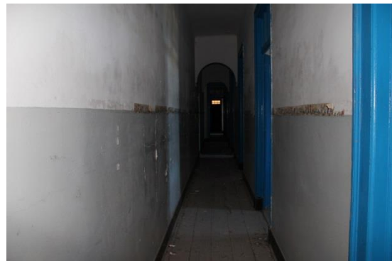
Figura 23- Corredor do piso 1
