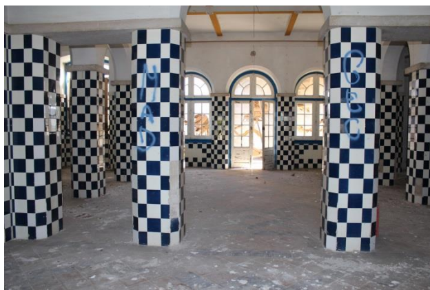
Figura 10- Zona central do edifício
