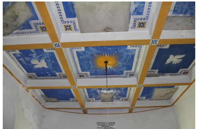
Figura 9- Teto da zona de entrada
