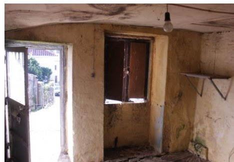
Figura 8 - Divisão á entrada da casa. Foto: Inês Valente
