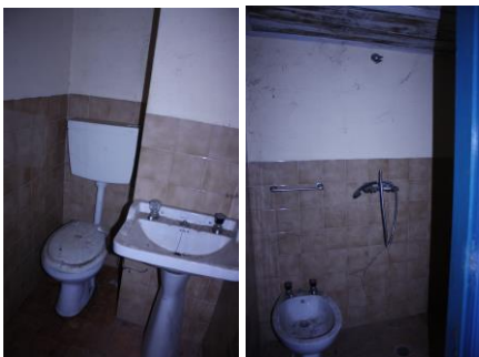
Figura 13- A casa de banho existente na habitação. Foto: Inês valente
