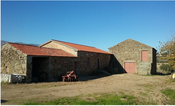
Figura 3_ Vista exterior da habitação (frente)
