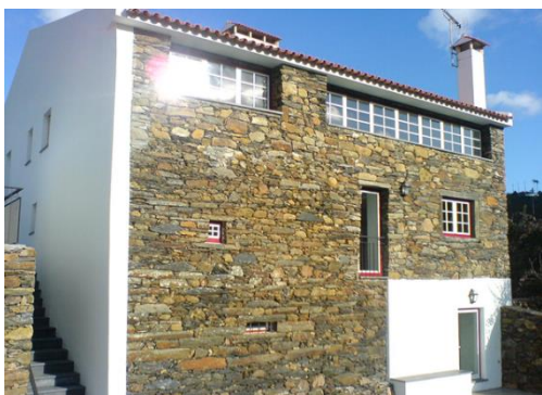
Figura 8 - Fachada exterior com xisto
