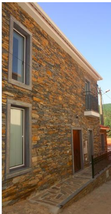
Figura 6 - Exterior com rampa
