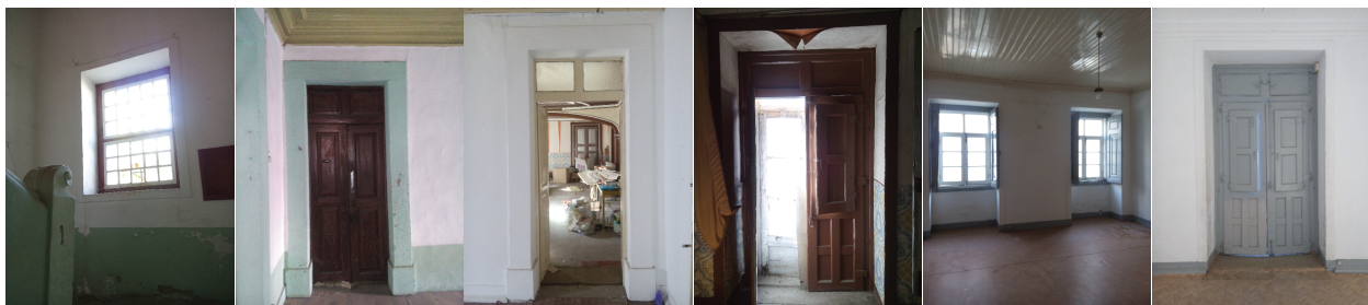
Figura 5: Vão de janela do patamar das escadas principais; Porta de hall de escadas piso 1; Porta da sala central, piso1; Portadas de janela sala piso 1; Portadas de janelas de salas, piso 1; Portadas de janela de sala, piso 1;
