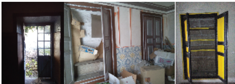
Figura 6: Porta de metal que colmata o corredor de distribuição do piso 0 e culmina no pátio interior; Armários embutidos de salas do piso 1; Armário embutido de salas do piso 1;
