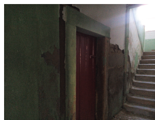
Figura 4: Hall de escadas, piso 0
