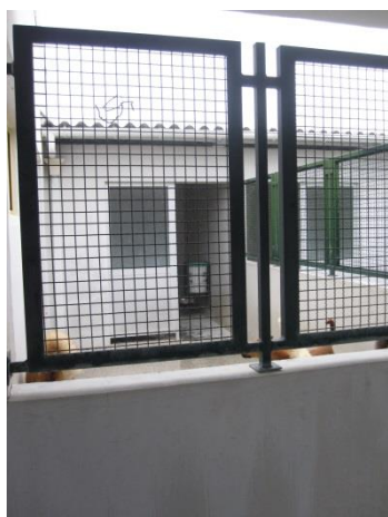
Figura 1: Falta de cobertura. Fotografia de autor.
