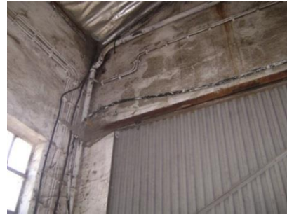
Figura 19: Infiltrações telhado
