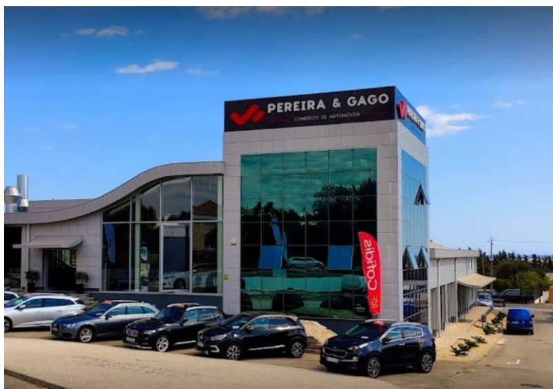
Figura 48. Sinalética Edifício - Pereira & Gago
