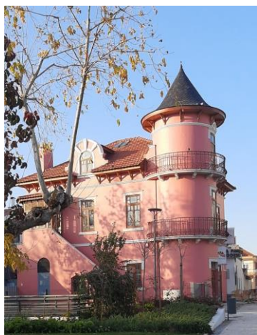
Figura 2- Fachada Esquerda a Sul; Fonte: Beatriz Cordeiro
