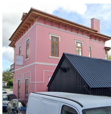
Figura 5- Fachada Posterior a Este; Fonte: Google Maps
