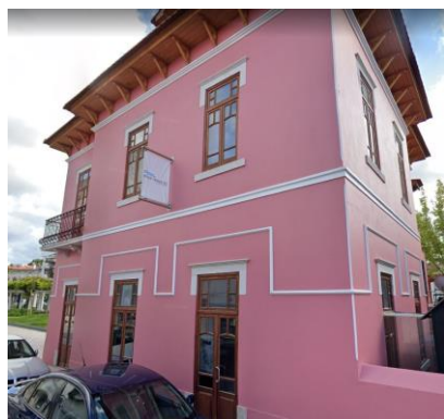
Figura 4- Fachada Direita a Norte; Fonte: Google Maps
