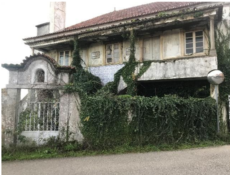
Figura 19- Fachada principal da casa | Fonte: Beatriz Fernandes
