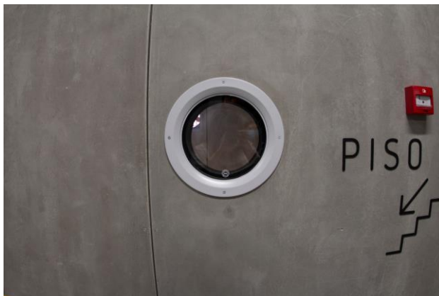
Figura 48 - Imagens do repérage realizado à fábrica da criatividade
